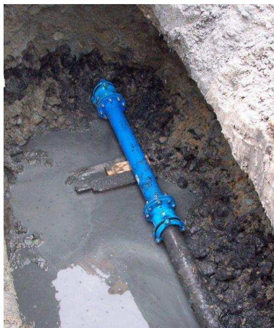
Oprava VŘ DN100 ul. Mládežnická
