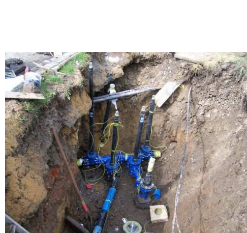
Vodovodní řad ul. Rovniny
