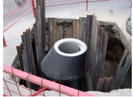
Kanalizace ul. Rovniny
