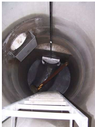
Kanalizace ul. Rovniny
