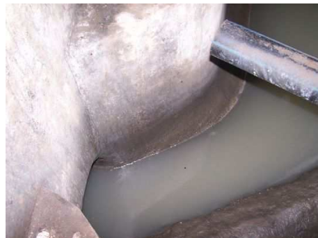
Kanalizace ul. Rovniny
