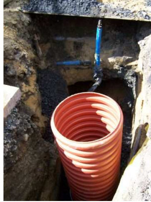
Kanalizace ul. Rovniny
