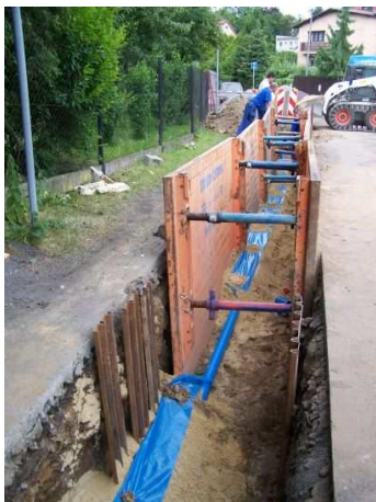
Vodovodní řad ul. Hluboká
