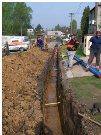
Vodovodní řad ul. Na Závodí
