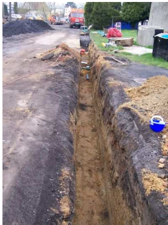
Vodovodní řad ul. Na Závodí
