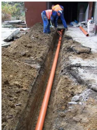
Kanalizace ul. U Bašty
