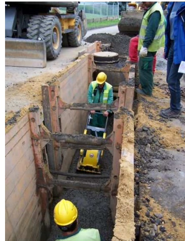
Kanalizace ul. Rovniny
