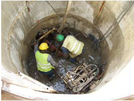
Kanalizace ul. Rovniny
