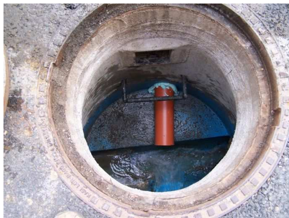
Kanalizace ul. U Bašty
