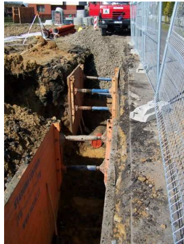
Kanalizace ul. Rovniny
