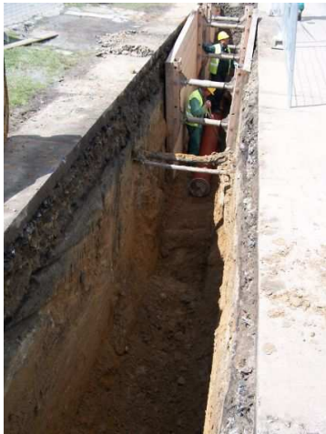
Kanalizace ul. Rovniny
