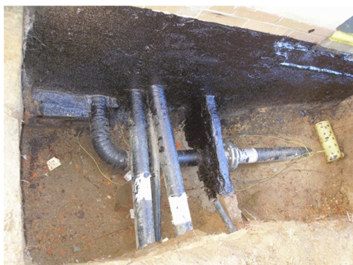
Výměna plynového potrubí AK plynojemu
