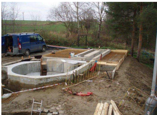
ČOV - bednění a armování lapáku písku
