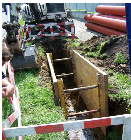
Kanalizace ul. Křivá
