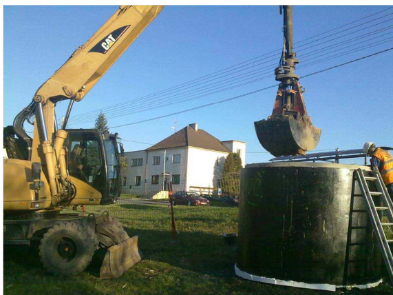
Kanalizace Rovniny - osazení první skruže
