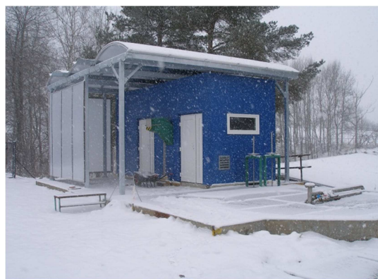
Nový objekt hrubého předčištění
