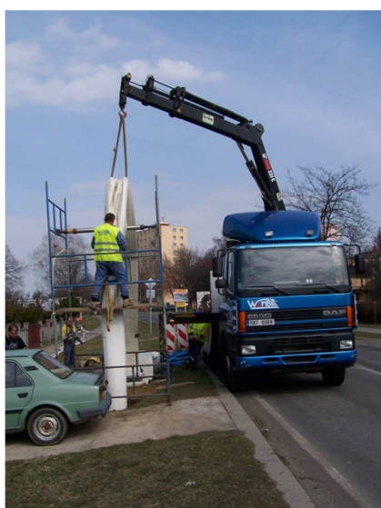
Sanace ul. ČSA
