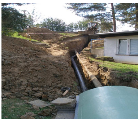
ČOV - nové výtláčné potrubí z KČS2
