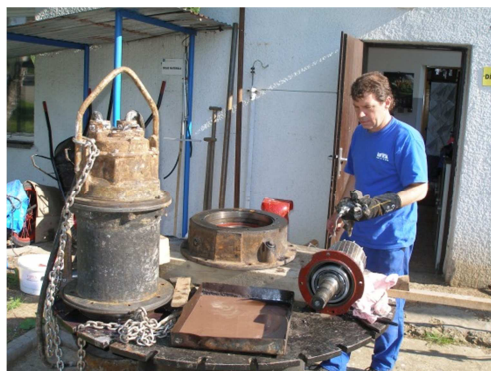
Oprava čerpadla FLYGT
