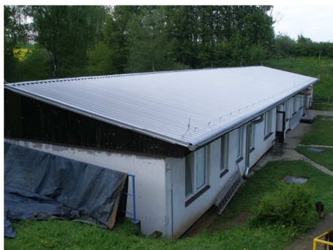
Nová střecha provozní budovy
