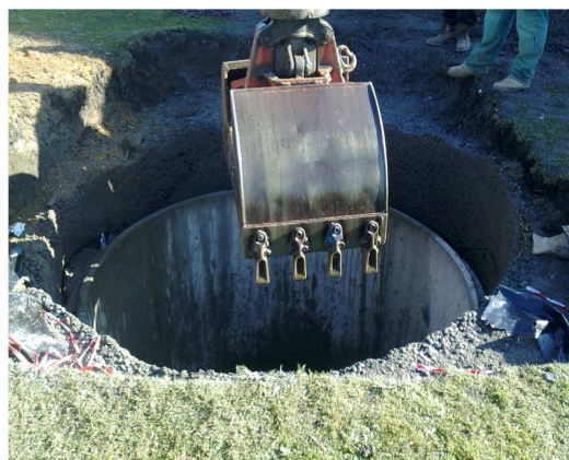
Kanalizace Rovniny – výkop šachty
