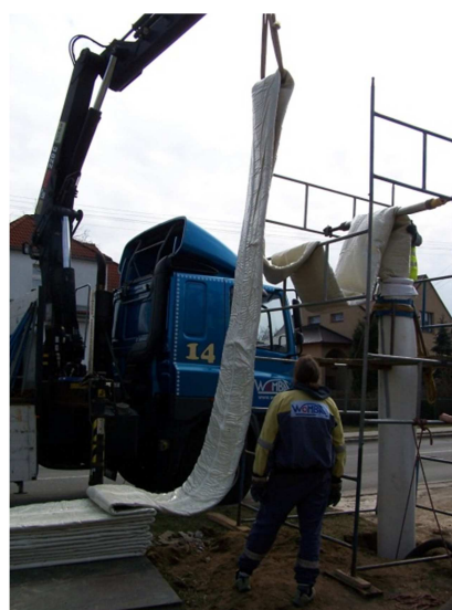
Sanace ul. ČSA
