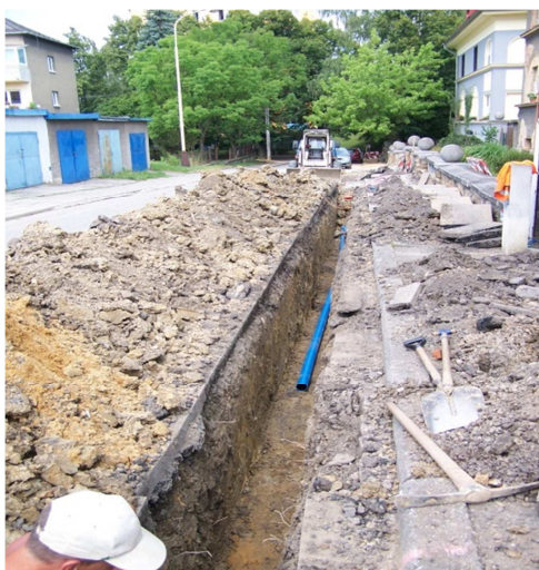
Vodovod ul. Tyršova
