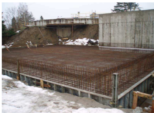
ČOV - bednění podlahy kryté skládky kalu
