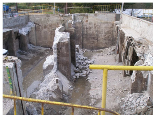
ČOV – bourání nádrže regenerace
