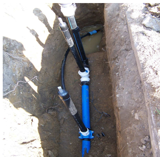
Výměna vodovodu ul. M. Majerové
