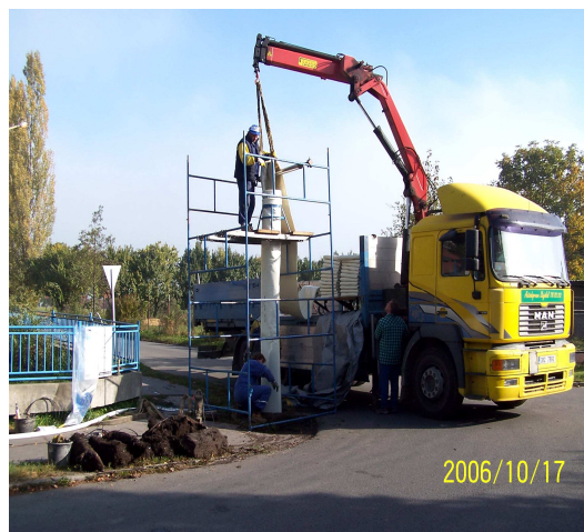
Vložkování kanalizace ul. Hornická
