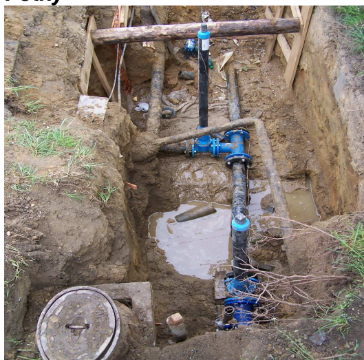
Výměna vodovodu ul. VI. Vančury
