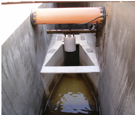
Nový Parshallův žlab
