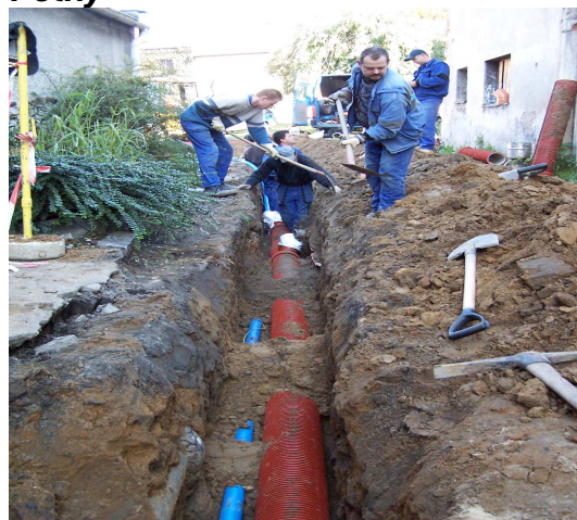
Oprava vodovodu a kanalizace Pode Zdí
