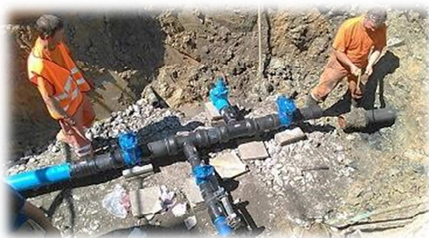
Oprava VŘ ul. Zahradní
