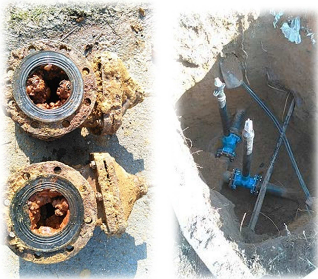
Výměna šoupátek ul. Okružní
