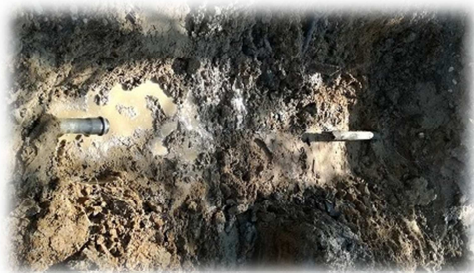
Poškození VŘ ul. ČSA
